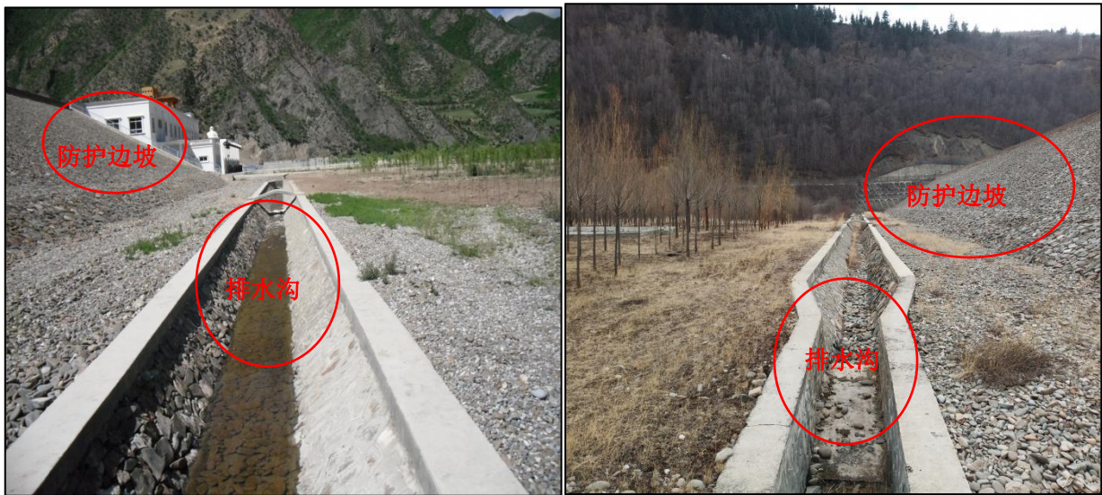
图 2-20 边坡防护及排水沟
