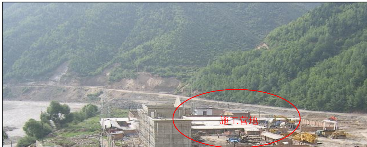
图 3-6 施工期施工营地
