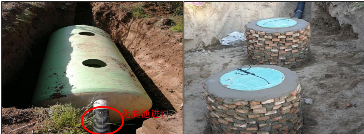
图 2-4 化粪池施工照片
