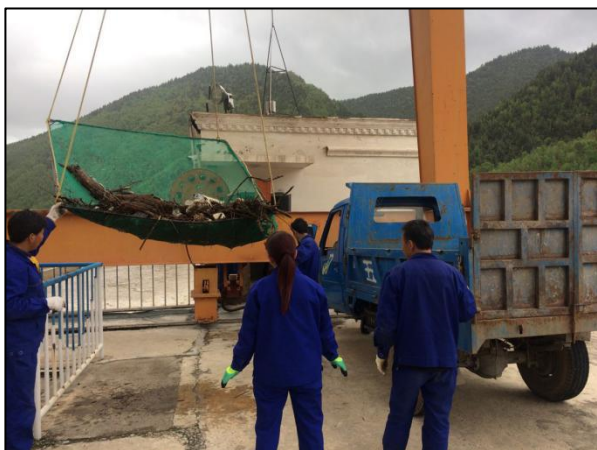
图 2-15 水电站库区漂浮物清理
